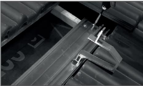
Wechselgrundplatte mit je 2 Tellerkopfschrauben am Sparren montieren.
