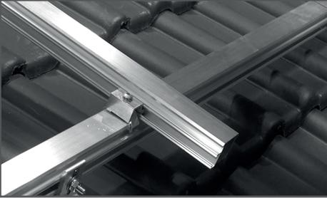
Kreuzverbinder aufklicken und in die Hammerkopfnut des Oberprofils einführen.
