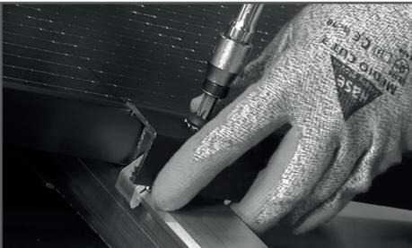
Drücken Sie die Endklemme bei der Montage an das Modul
