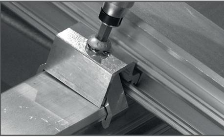
Kreuzverbinder mit Drehmomentschlüssel fixieren.
