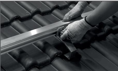
Mutter in die Hammerkopfnut einführen und handfest anziehen.
