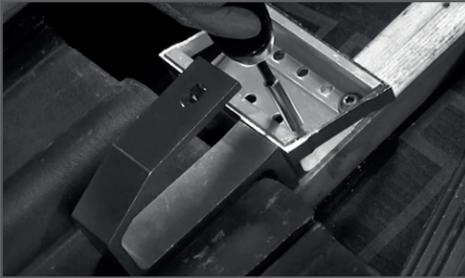
Dachhaken mit 2 Tellerkopfschrauben am Sparren montieren. Die Schrauben sollten mindestens 60mm im Sparren verschraubt sein.
